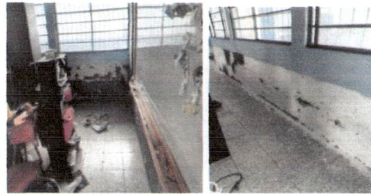
Foto 2: 2do, C, esta pared sera repellada por causa se humedad. Posteriormente se pintara
