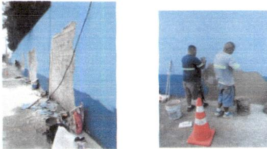
Foto 1: pared exterior esta en muy mal estado, se cae el repello, tiene humedad en gran parte de ella.
