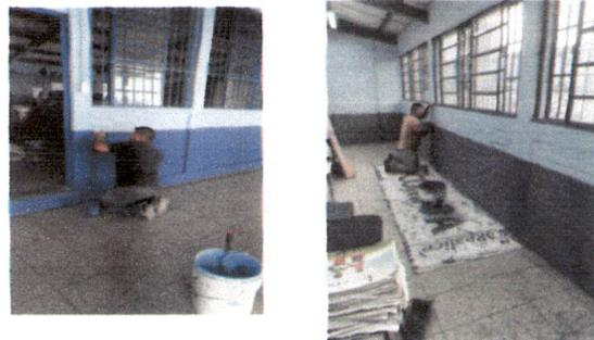
Foto 6: cambio de pintura en varias paredes por humedad
